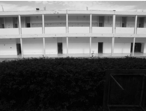
Clădirea Centrului de Artă digitală din Holon / The building of Center for Digital Art in Holon.
